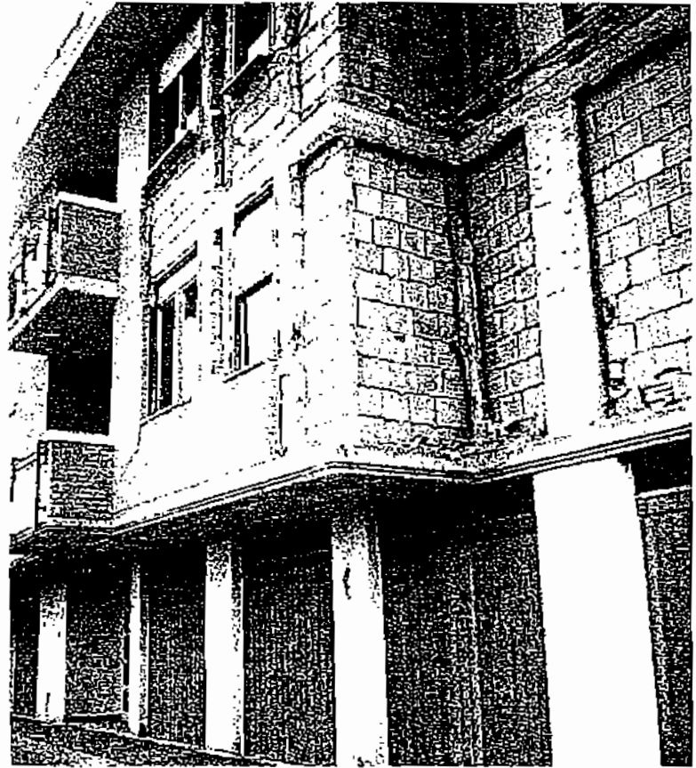
Figura 4.34 Ribaltamento totale di cortine in mattoncini non collegate alla struttura principale. Livello del danno per le tamponature: D4 (Fabriano, 1997)
