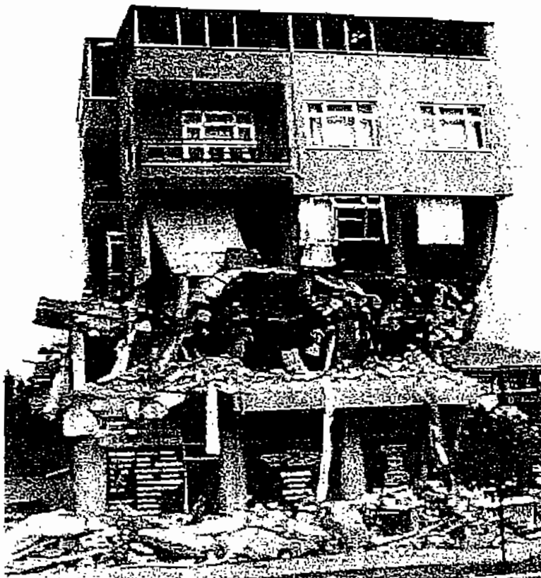
Figura 4.35 Danno gravissimo a struttura a telaio di cemento armato, con distruzione di parte dei pilastri del primo piano e del solaio del secondo. Livello del danno: D4-D5 (Turchia, 1999)
