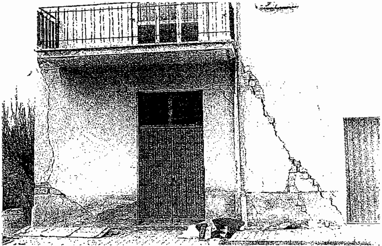
Figura 4.20 A sinistra lesioni verticali da distacco (tipo 7); lesione diagonale (tipo 3) sul maschio tra le due porte. La muratura è in blocchi di tufo. Livello del danno alla parete: D3
