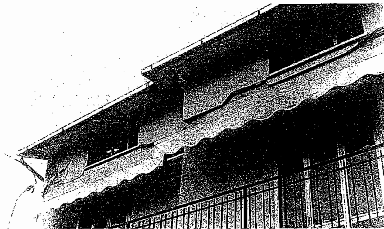
Figura 4.15 Grave dislocazione a livello del cordolo di sottotetto per spinta della copertura in cemento armato (tipo 12; la lesione si presenta simmetricamente sulla parete esterna parallela opposta); lesione angolare (tipo 9). Livello del danno: D4-D5 (Busche, PG, 1998)
