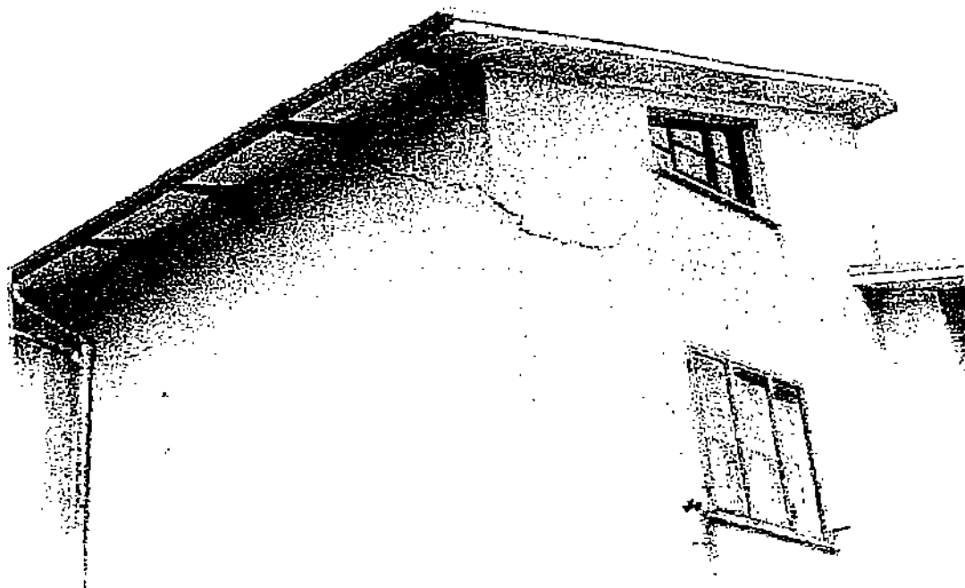
Figura 4.13 Lesione con distacco di spigolo sottotetto (tipo 9) Livello del danno: D2-D3 (Cerqueto, PG, 1998)
